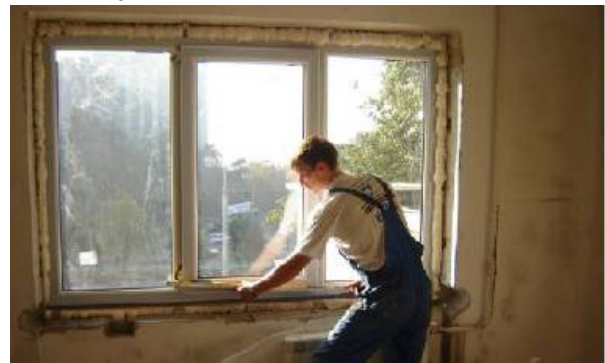
hier der Einbau neuer Isolierfenster
